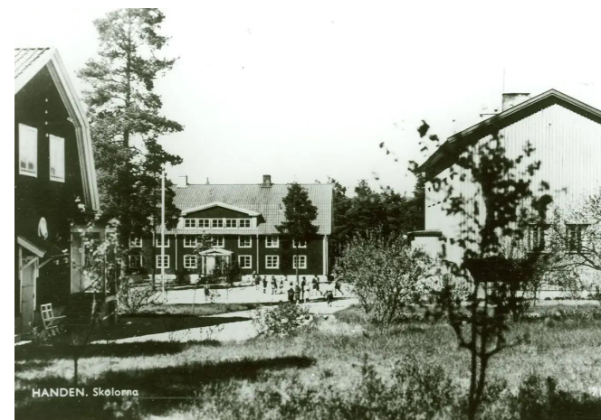
Bilden visar de första skolbyggnaderna i Handen. Rakt fram "Röda skolan" som brann ned 1946. T.h: "Gula villan" som uppfördes i stationssamhället år 1927. Källa: Stockholms läns-museum
