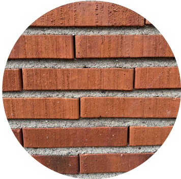
Det röda smala teglet i halvstensförband och släta (möjligen kratsade) fogar.
