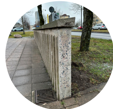
Utsmyckade betongdetaljer. Här en mur med exponerad ballast.
