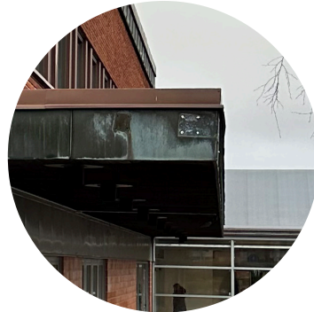
Nedragad kopparplåt med synliga falsar.
