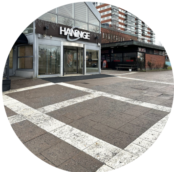
De ursprungliga betongplattorna lagda i rutmönster.
