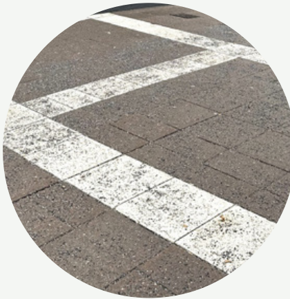
Det ursprungliga betongplattorna lagda i rutmönster
