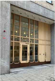
Referens, sockel och entré med rundade hörn, arkitekt Dinell/ Johansson.
