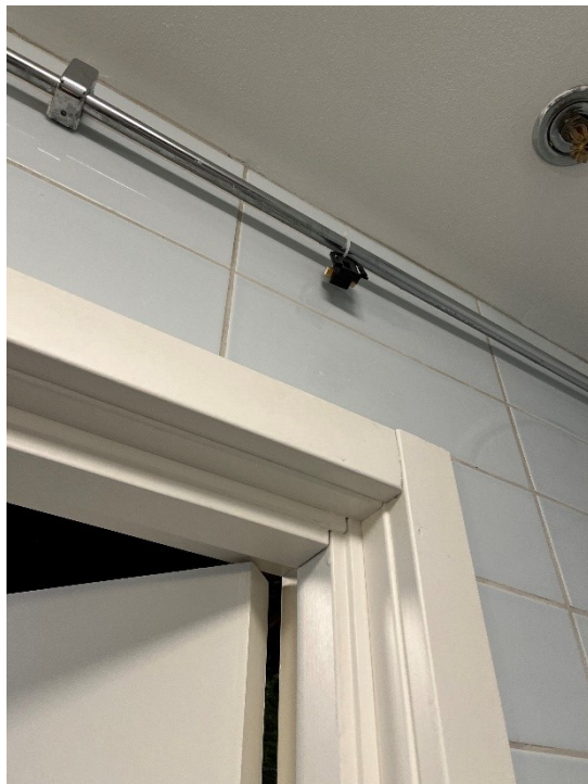
Figur 13: 25WIL4, toalett på en restaurang
