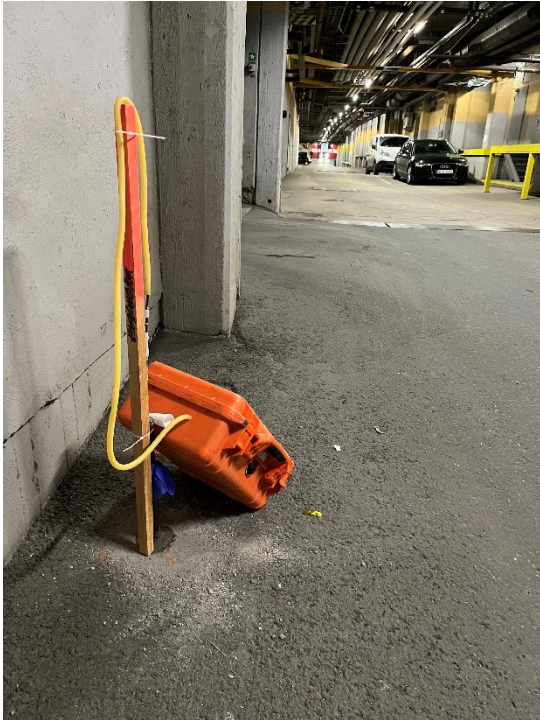
Figur 1: 25WPL1 vid pågående provtagning
