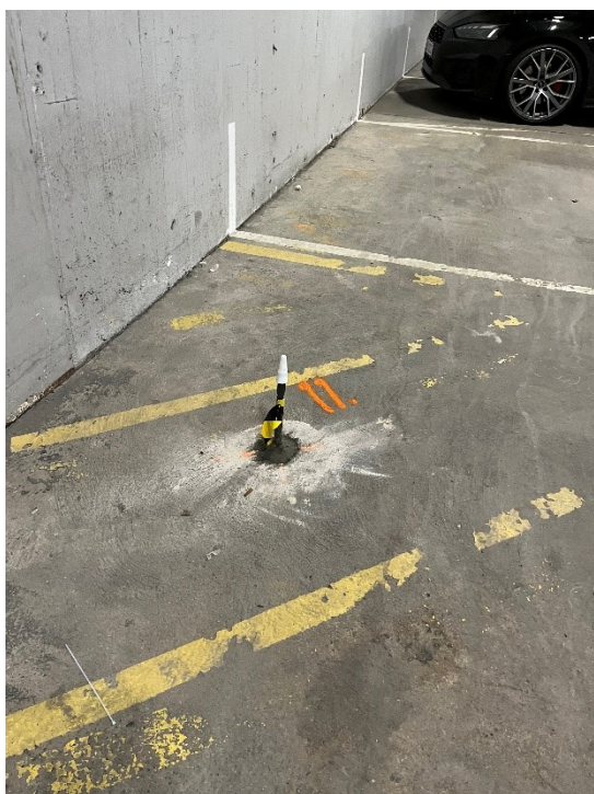
Figur 7: 25WPL11 efter installation av sond
