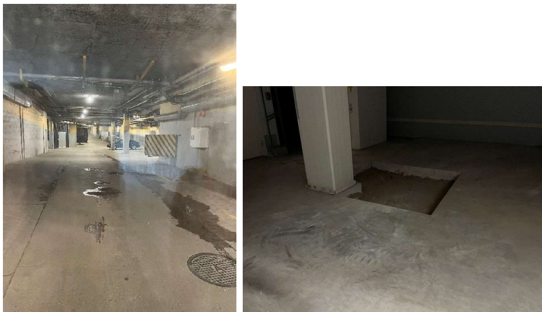
Figur 8. Transportgång under centrumbyggnaden (vänster bild) samt upptaget golv i en tom butikslokal i nordvästra hörnet av köpcentrumet (höger bild) där provtagning av porluft planeras.
