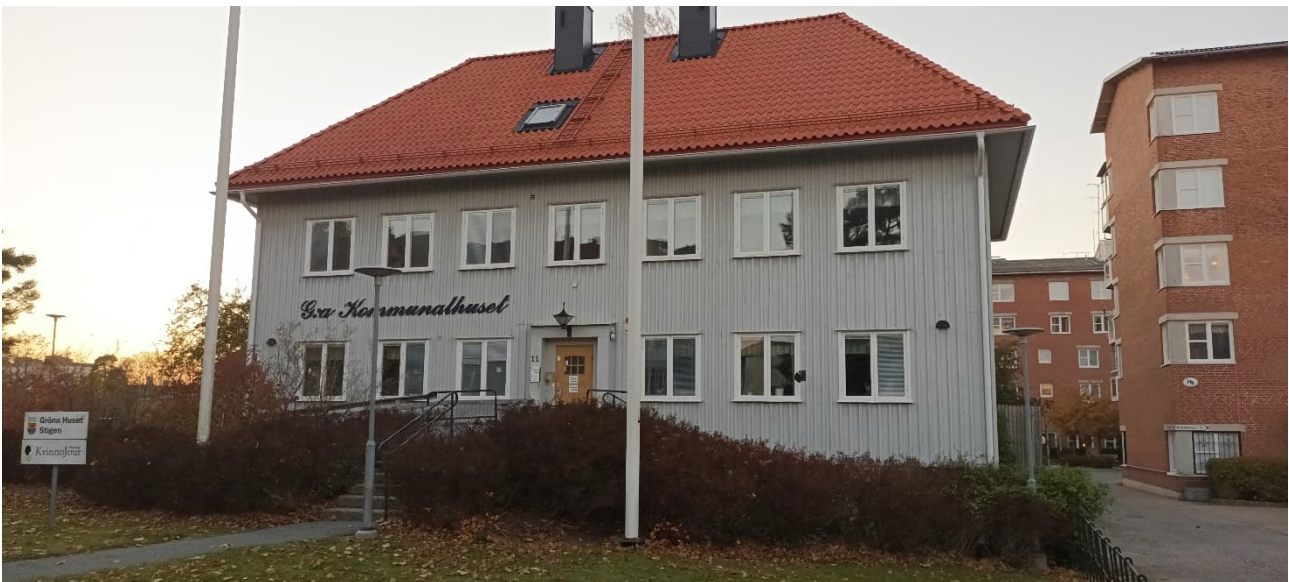
Figur 12: G:a Kommunalhuset från Runstensvägen. Foto taget vid platsbesök 2024-10-25
