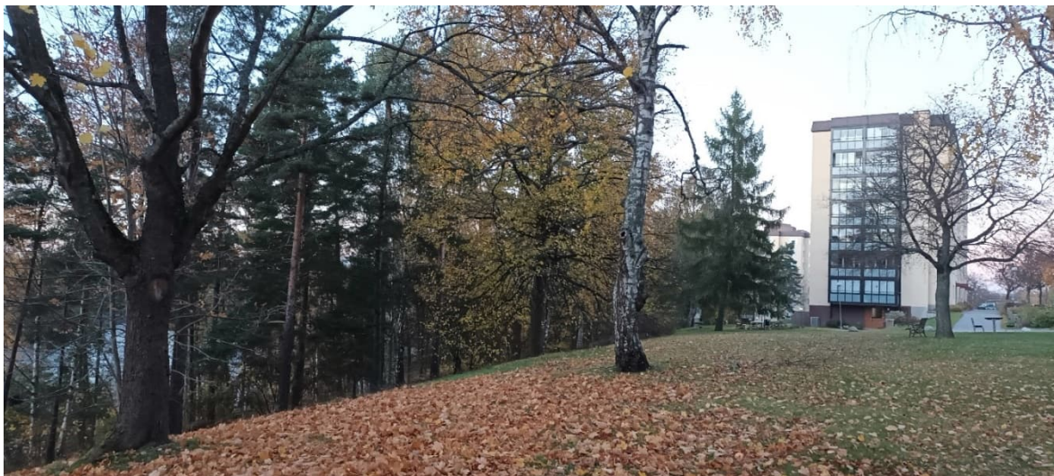
Figur 19: Flerbostadshus inom Kv Cypressen, byggt på kanten av sluttning ner mot järnvägen och Övre Rudansjön. Foto taget vid platsbesök 2024-10-25
