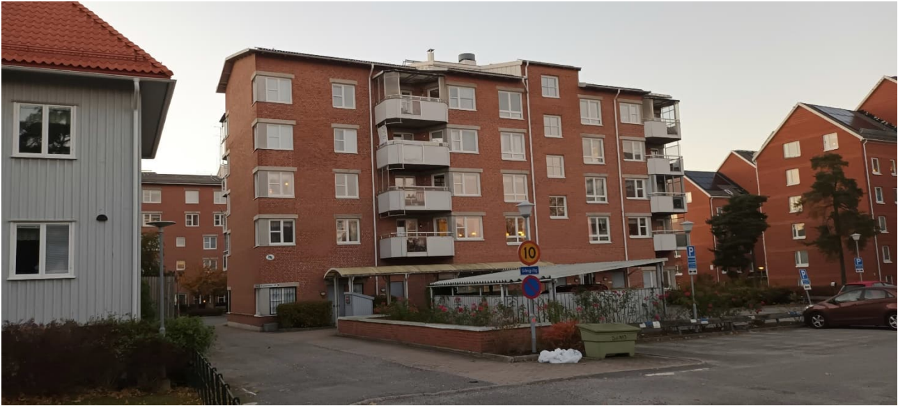
Figur 11: Servicehus/äldreboende - Söderbymalm 3:469 och 3:471 från Runstensvägen. Foto taget vid platsbesök 2024-10-25
